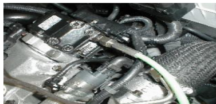
A mérővezetékek bekötése
